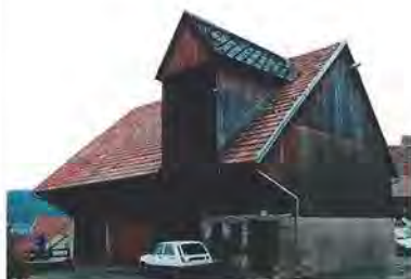
Toiture avec "grand chien-assis"
