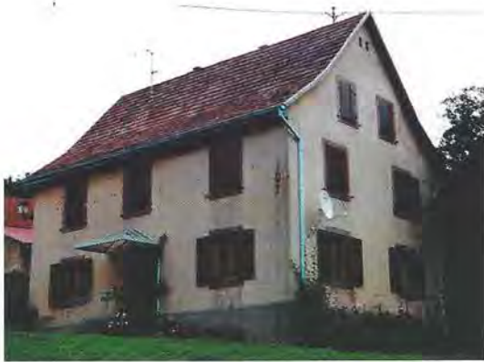
Toiture à coyaux
