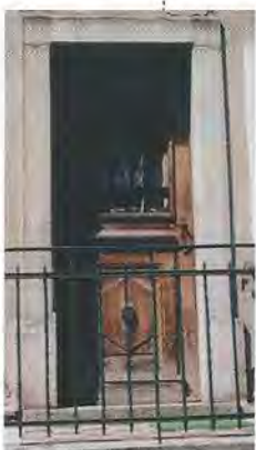
Portes et fenêtres avec leurs encadrements en pierre taillée
