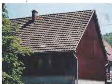
Transformation de la grange en habitation
