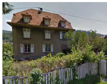
Ferme à cour ouverte, début 20 e s. : 1 rue de Breitenbach
